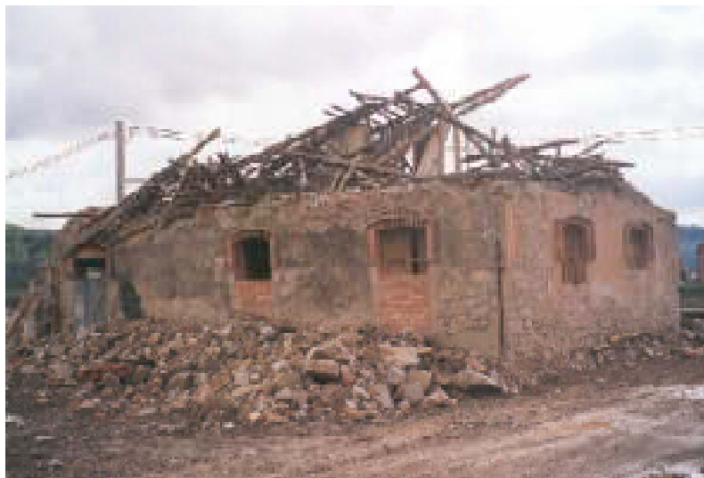
Una vista de la fàbrica abans de ser enderrocada
